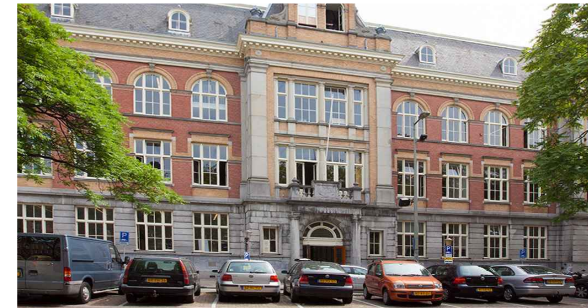
gevel HES gebouw
