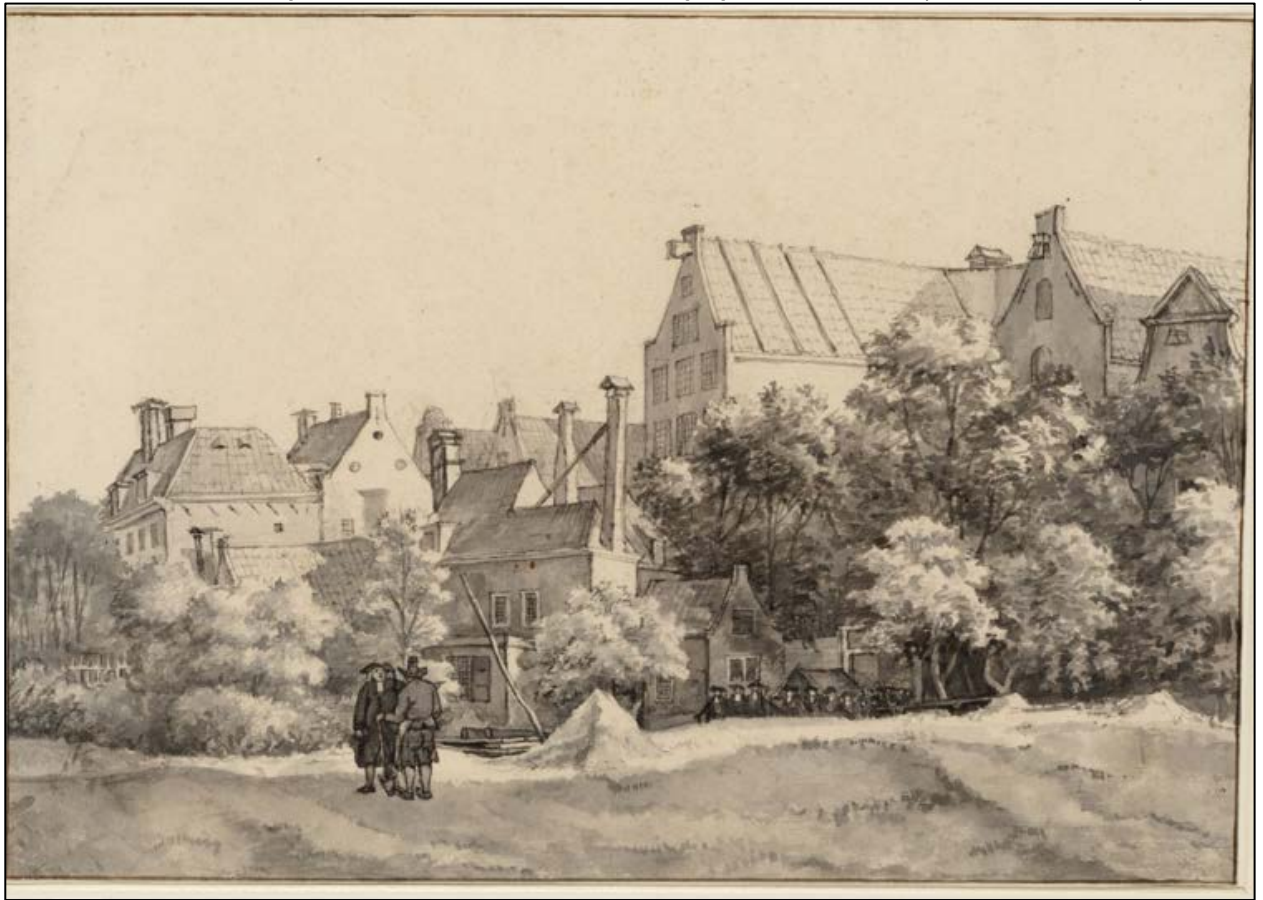
Figuur 21. Tekening van het Leidsche Kerkhof uit 1812, door Gerrit Lamberts, met op de achtergrond bebouwing langs de Raamstraat. Een begrafenisstoet betreedt het terrein via de ingang aan de Raamstraat (bron: SAA, Beeldbank).
