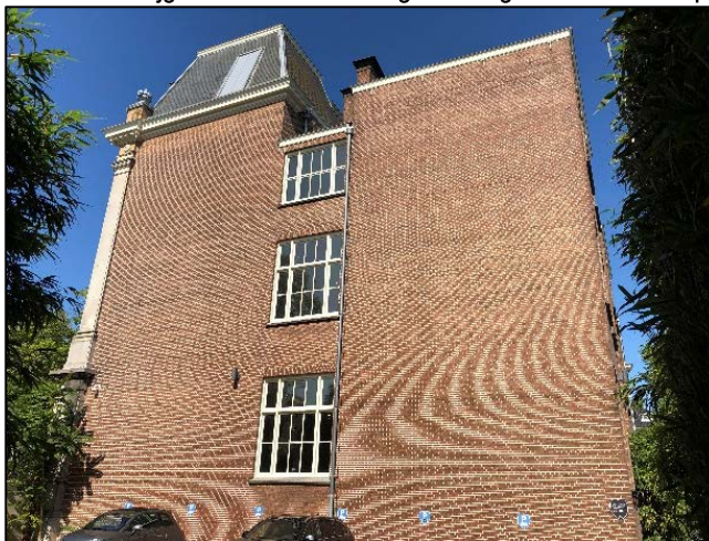
Figuur 48. De zijgevel van het voormalige schoolgebouw aan Raamplein 1 met in het midden de bestaande ramen
