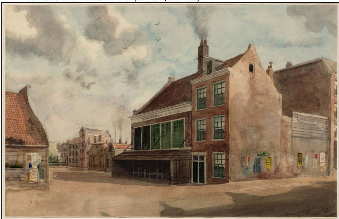
Figuur 26. Tekening van een deel van het Malagaplein uit 1896, door H.M.J. Misset. Met op de achtergrond de Raamstraat en rechts de Marnixstraat (bron: SAA, Beeldbank).
