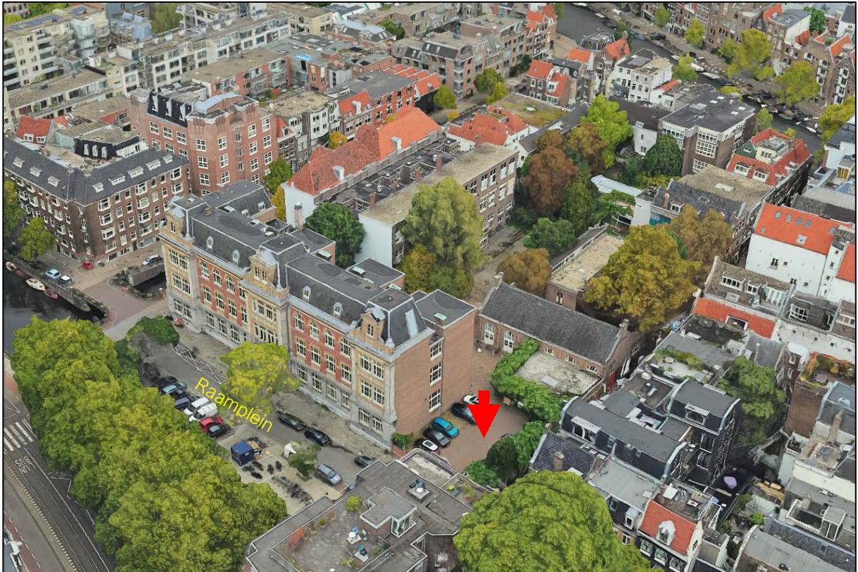
Figuur 43. Vogelvluchtweergave van het bouwblok waarbinnen de met een rode pijl aangegeven projectlocatie is gelegen en het schuin links daarvan gelegen Raamplein (bron: https://www.google.nl/maps )
