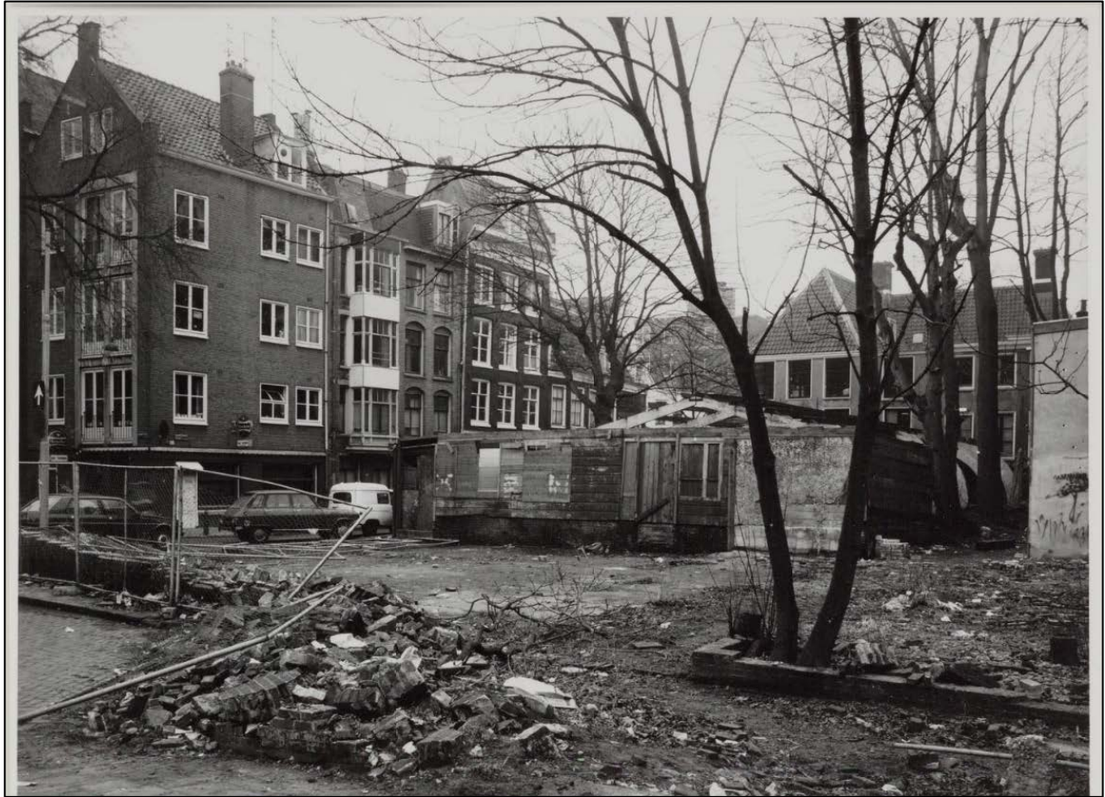
Figuur 31. Foto van Raamplein 2-6 na de sloop uit 1985. Hierbij is een groot gedeelte van het bouwblok tussen Raamplein, Raamdwardsstraat, Leidsegracht en Marnixstraat gesloopt (bron: SAA, Beeldbank).
