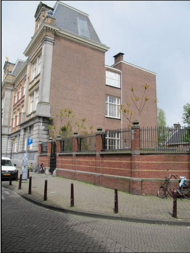
Figuur 39. De zuidelijke korte gevel van het schoolgebouw van de Handelsschool, met in het midden de vensters van de corridors. In de kap bevindt zich de deur voor de inmiddels verdwenen hijsinstallatie. Op de voorgrond de oorspronkelijke gemetselde afscheiding met ijzeren hekwerk die de binnenplaats afsluit, met links het toegangshek naar de binnenplaats (bron: foto de Erfgoed Praktijk, 2012).
