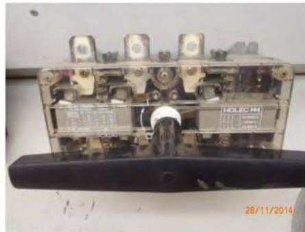
Toelichting bij foto 4: Schakelaar Holec type Dumeco S32e/3 500A
