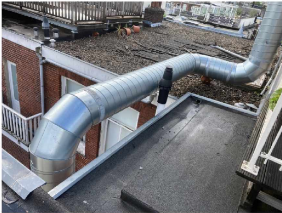
Dak terras 4e verdieping afvoerkanal versleedt, deels over het dak van Willemsparkweg 218.
