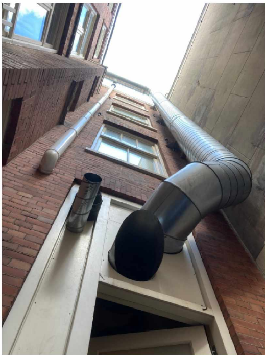
Gevel achterzijde van het restaurant (hoekpand).
