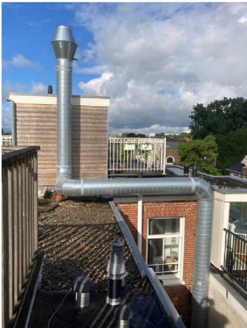
Dak terras 4e verdieping afvoerkanal versleedt, deels over het dak van Willemsparkweg 218.
