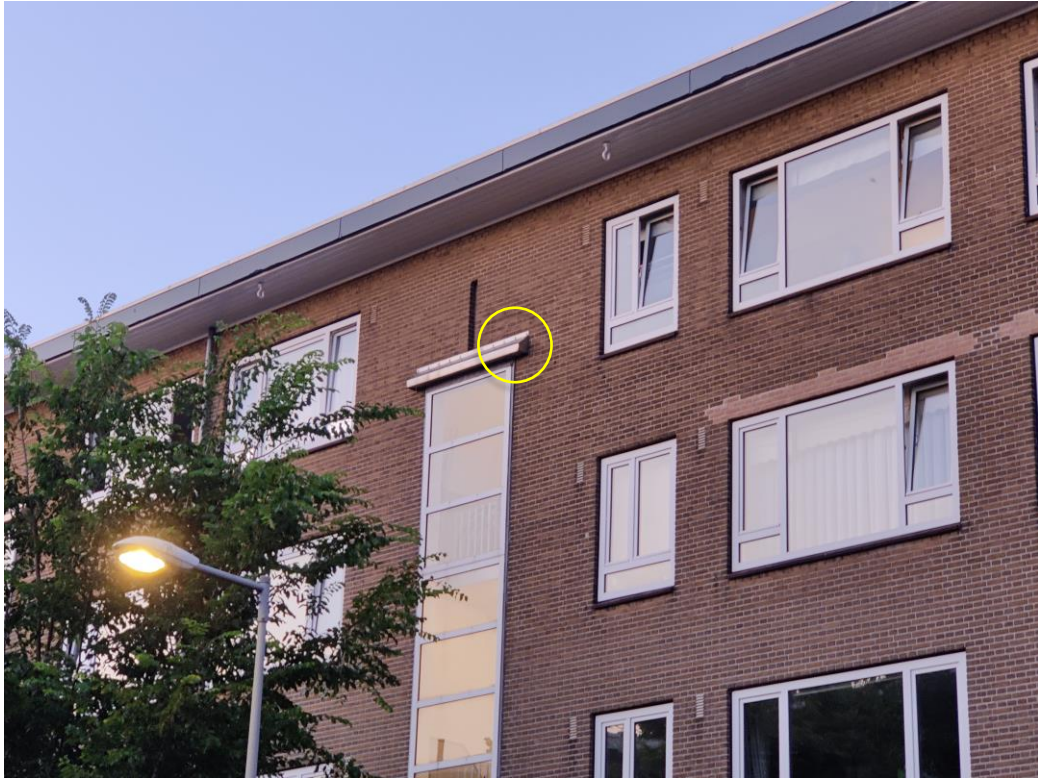
Figuur 3.3 Onder de aluminium daklijst ter plaatse van het trappenhuis van het appartementencomplex aan de Grenadierstraat 64/66 is een invliegende gierzwaluw waargenomen.
