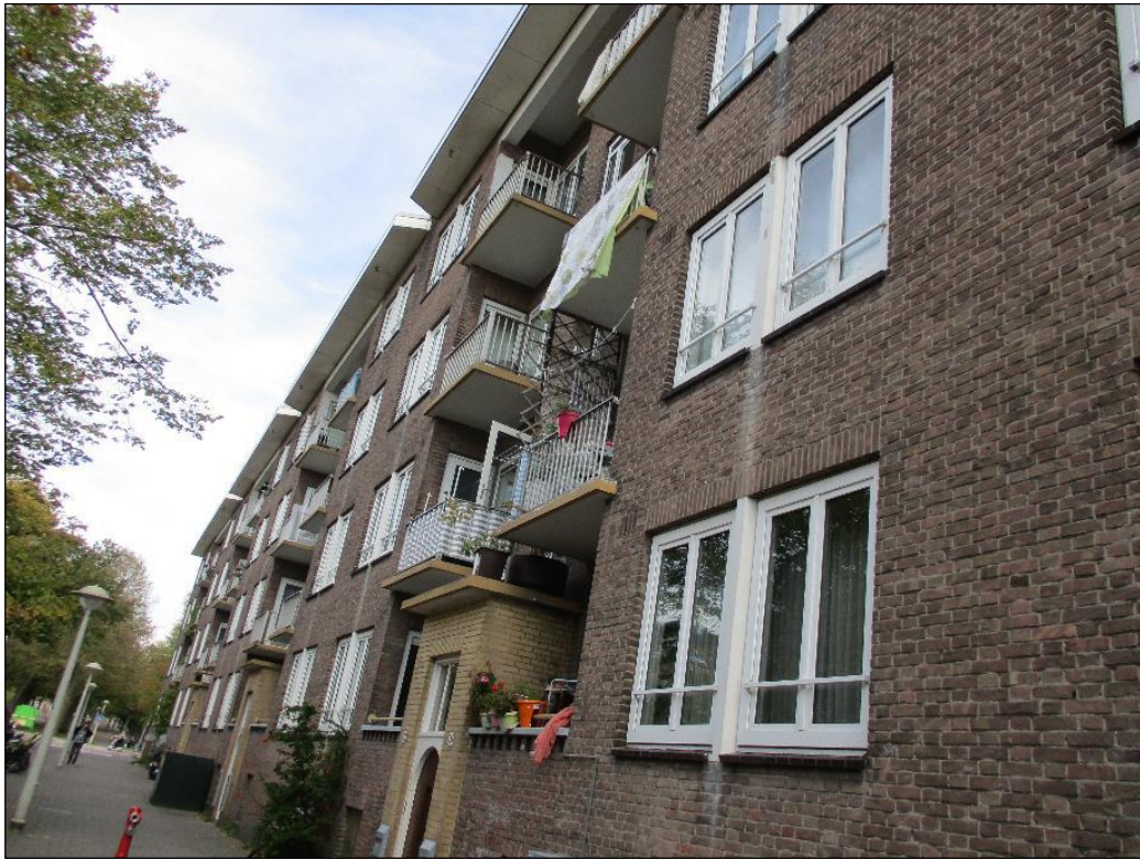
Figuur 1.2 De bebouwing op de planlocatie bestaat uit 2 aaneengesloten appartementencomplexen.
