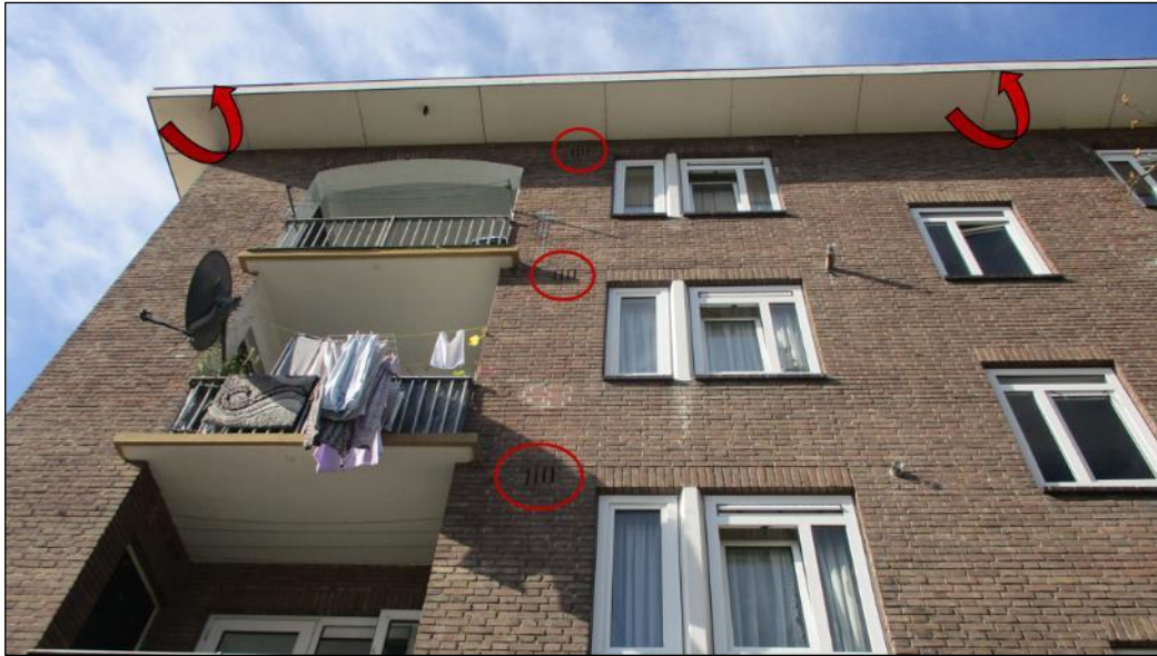
Figuur 1.3 Middels open stootvoegen, kierende daklijsten en andere openingen kunnen vleermuizen toegang krijgen tot potentiële verblijfplaatsen in de bebouwing op de planlocatie.
