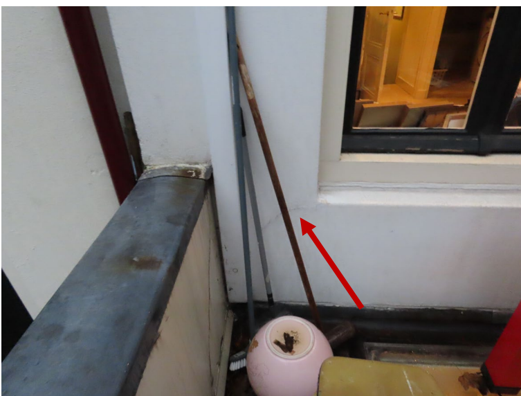
Figuur 18 – Achtergevel hoofdvolume vanaf dakterrasniveau.
