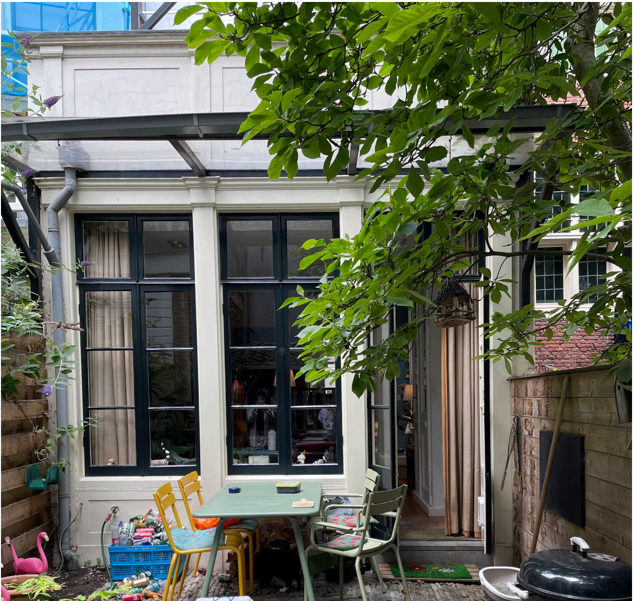
Figuur 17 – Achtergevel achterruitbouw.
