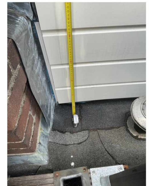
bouwhoogte dakopbouw bure nr 5.1.2.e = 2800mm + 200mm opstand bitumen = ca. 3000mm
