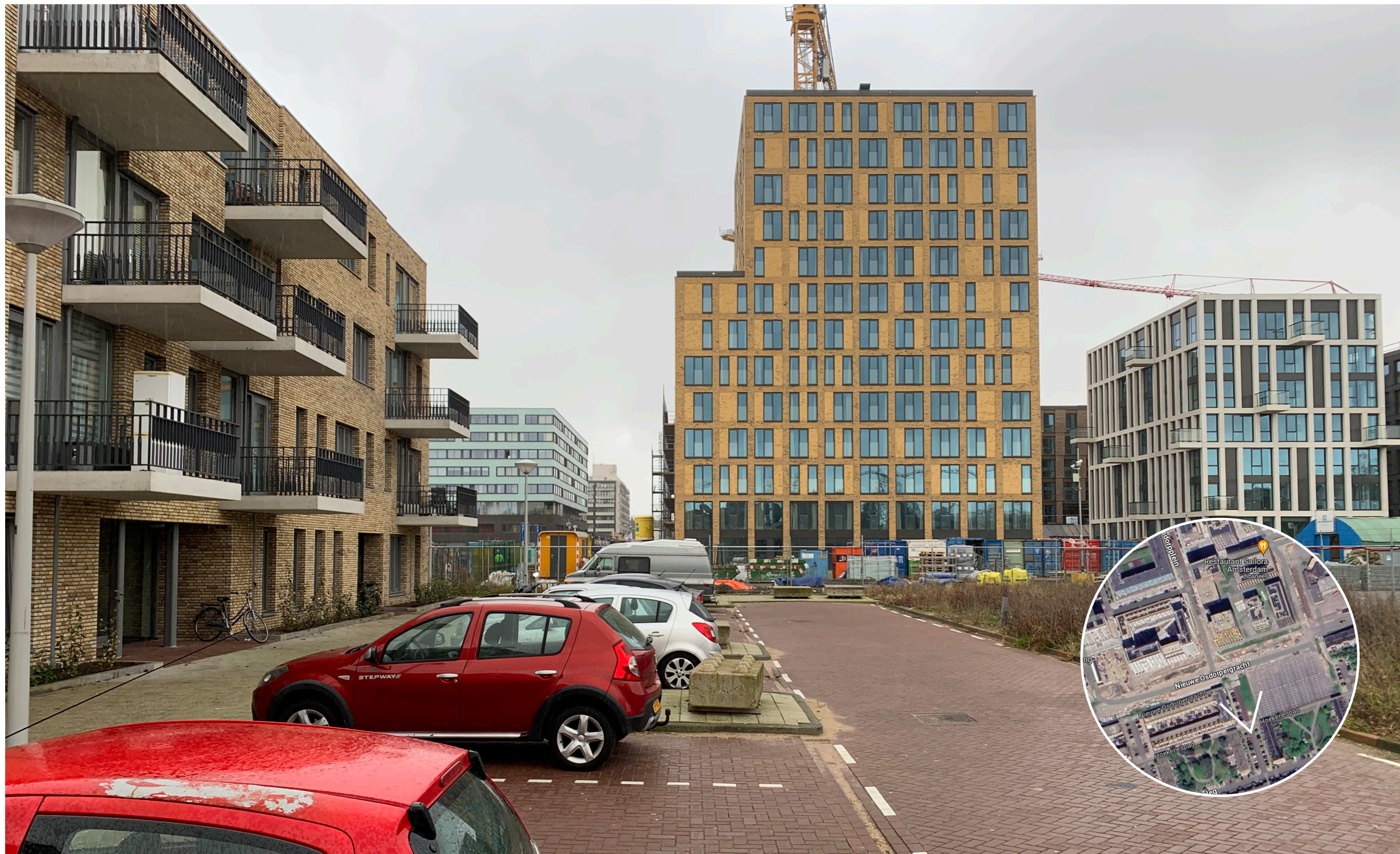
links: Eengezinswoningen met kopblok-appartementen aan het Hoekenespad, midden-rechts: Nieuwe blokken in Osdorp Centrum aan de overzijde van de Nieuwe Osdorpergracht
