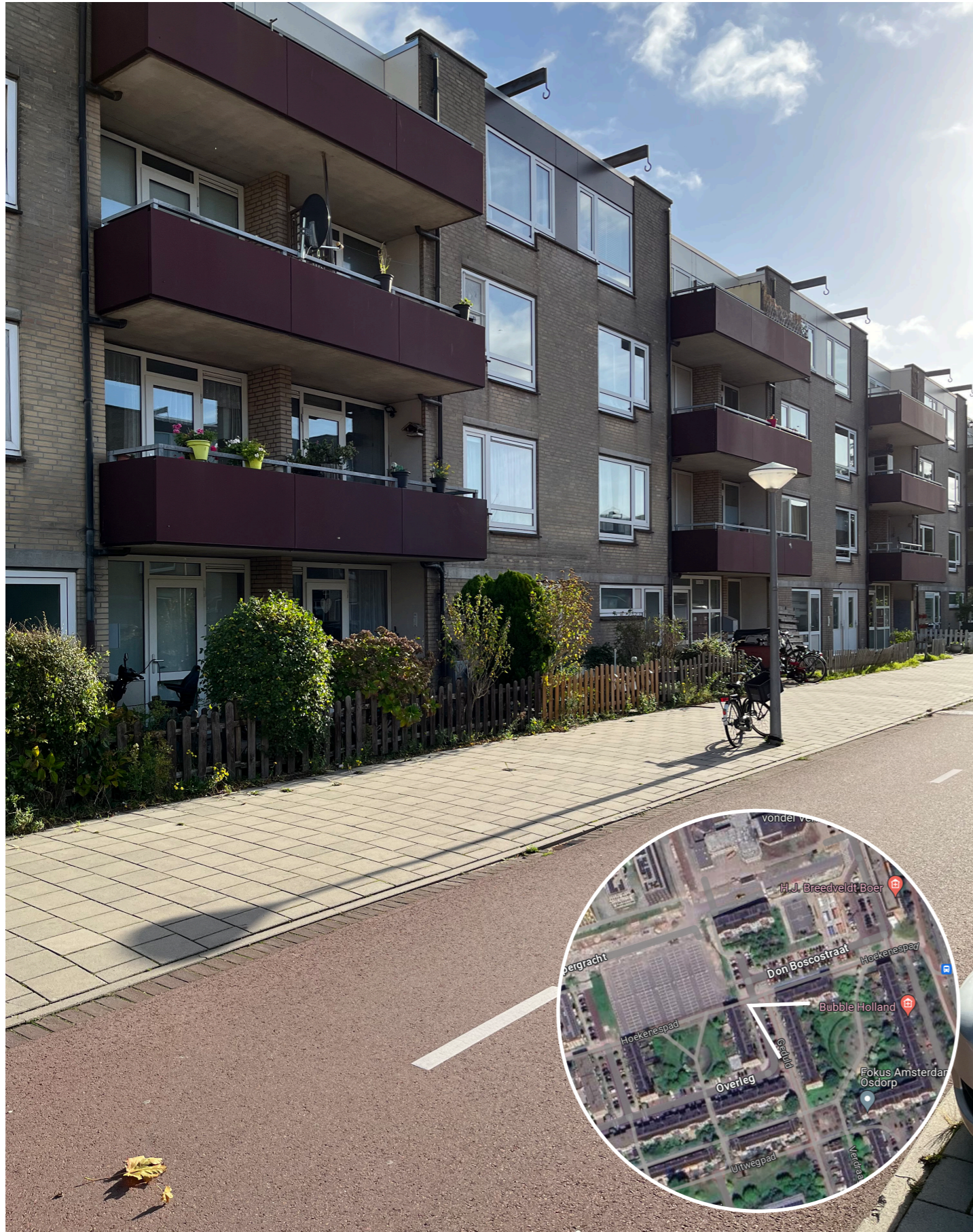
Appartementen in stroken aan Geduld.
