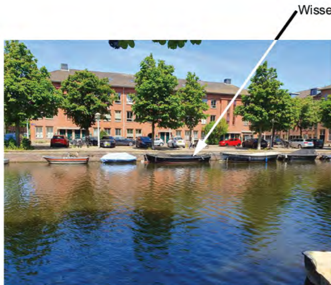
6. Aanzicht wisselplek De Rijpgracht 18S vanaf overzijde gracht
