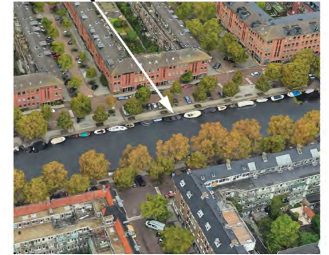
4. Overzicht wisselplek De Rijpgracht 18S - (Google Maps)
