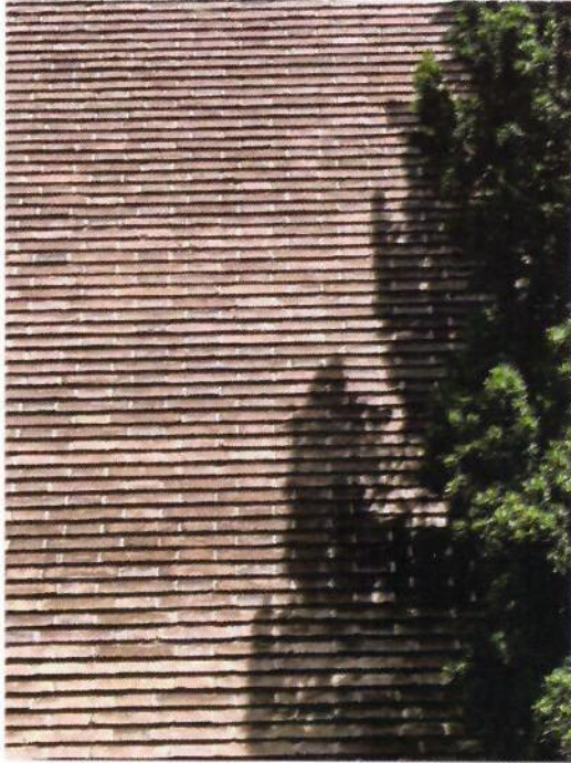
Detail van het metselwerk, dunne gele bakstenen in Vlaams verband
