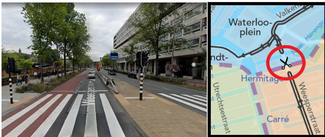
Locatie tijdelijke knip Weesperstraat, gezien vanaf de zuidkant
