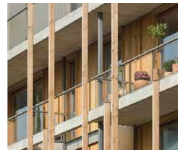
houten constructie galerij
