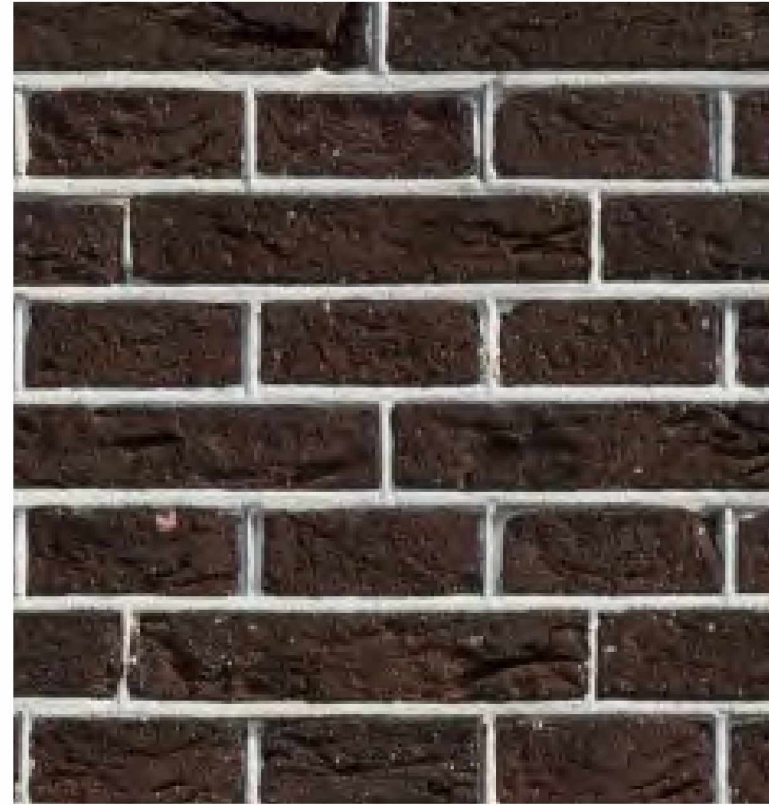
Bestaande metselwerk: vechtformaat, kruisverband met geknipte voeg
