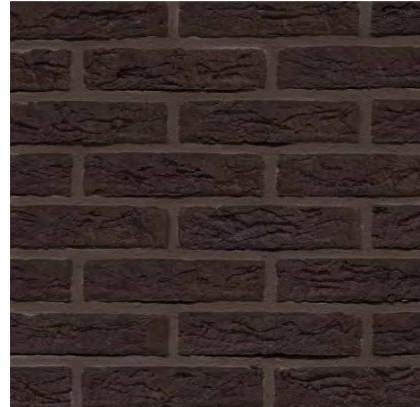
Nieuwe wanden met minerale steenstrips afgewerkt: Vergelijkbare steen, andere formaat en steenverband en andere kleur voegwerk
