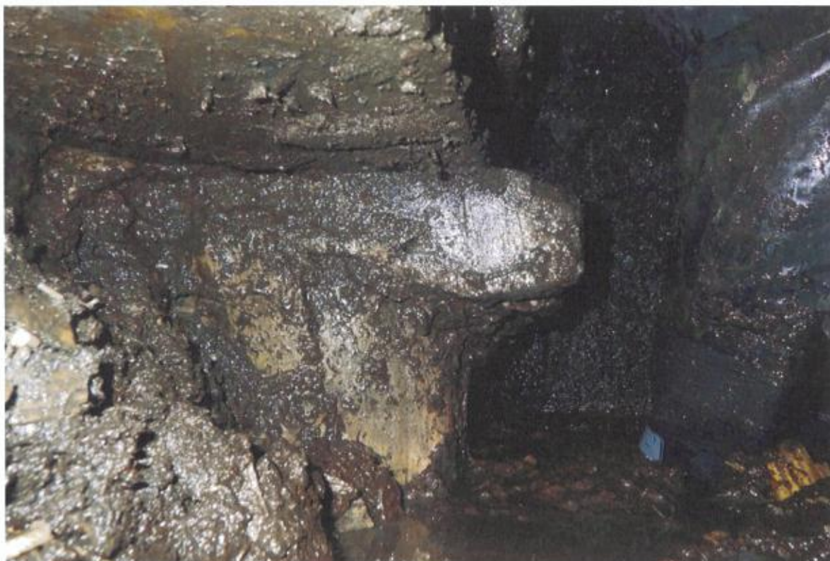
langshout 1, kesp 2 en paal 2 (kesp 2 is 50% samengedrukt)
