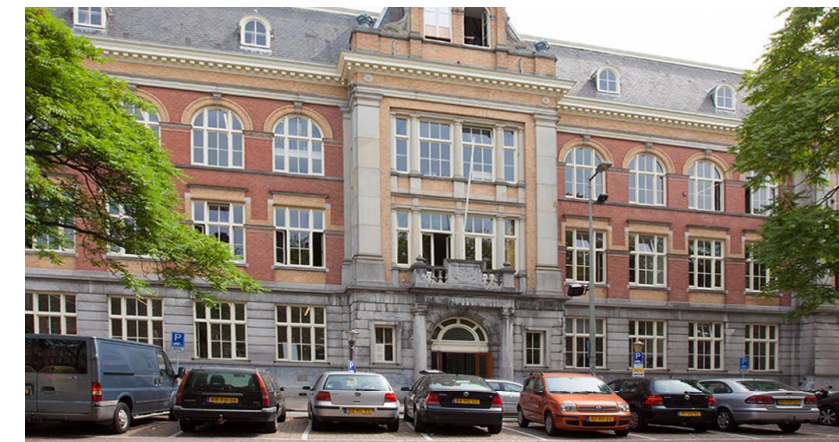
gevel HES gebouw
