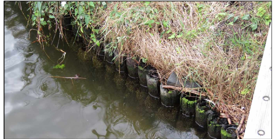
Figuur: de oever is beschoeid, waardoor waterfauna niet makkelijk in- en uit kan treden.
