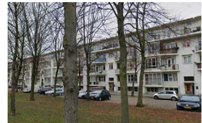
Het naar voren halen van erkers en balkons breekt de gevel.
