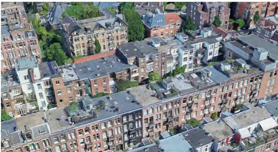
De bebouwing gezien van bovenaf, in zuidelijke richting. Geheel rechts de opbouw op het hoekpand aan de Brachthuiserstraat. De extra bouwlagen zijn nog niet gerealiseerd.
