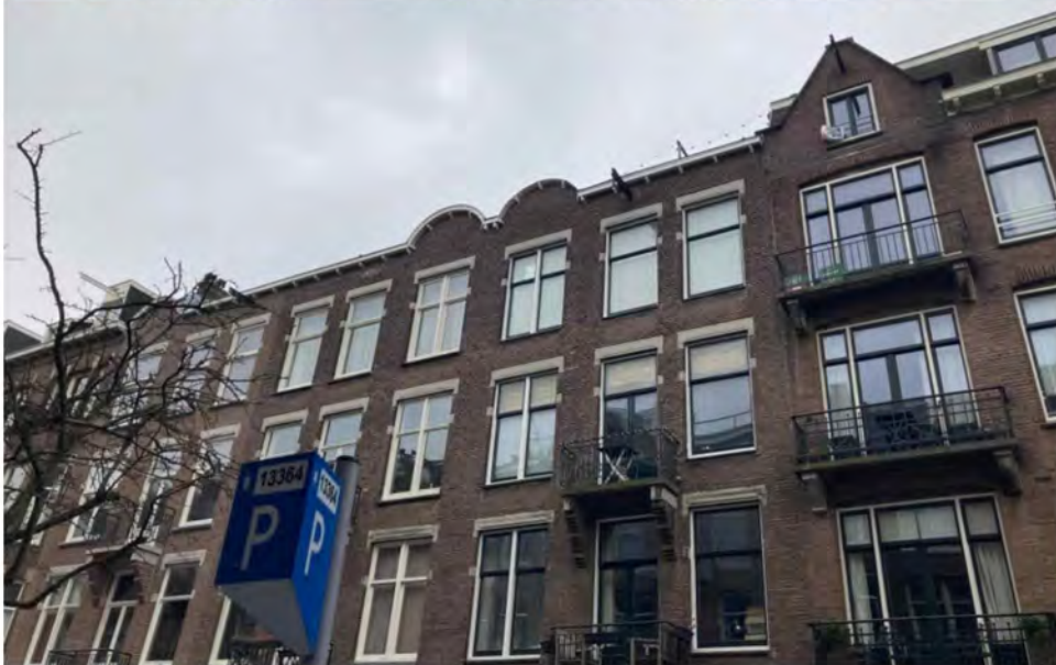
Gevelaanzicht vanaf de straat.
