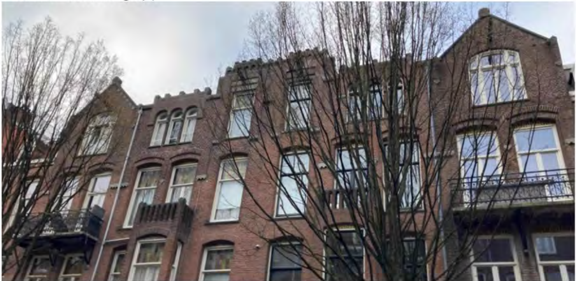
Gevelarchitectuur Nicolaas Maesstraat 66-76.
