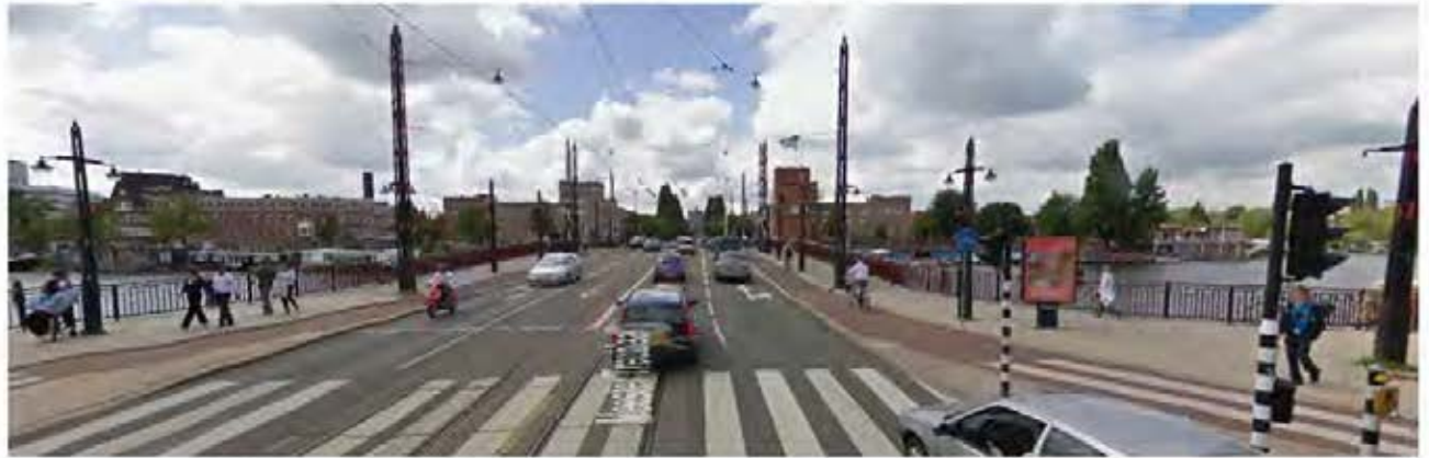
Figuur 2 - Streetview brug 423
