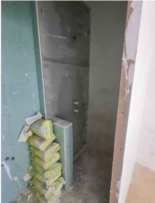
Figuur 41. Ventilatieschacht dichtgezet voor de 2 e en 3 e verdieping en mechanische ventilatie geplaatst voor de 2 e en 3 e verdieping.
