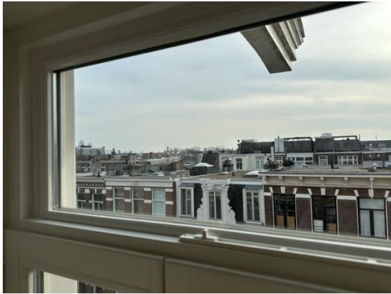
Figuur 46. de verwijderde haak van de hijsbalk
