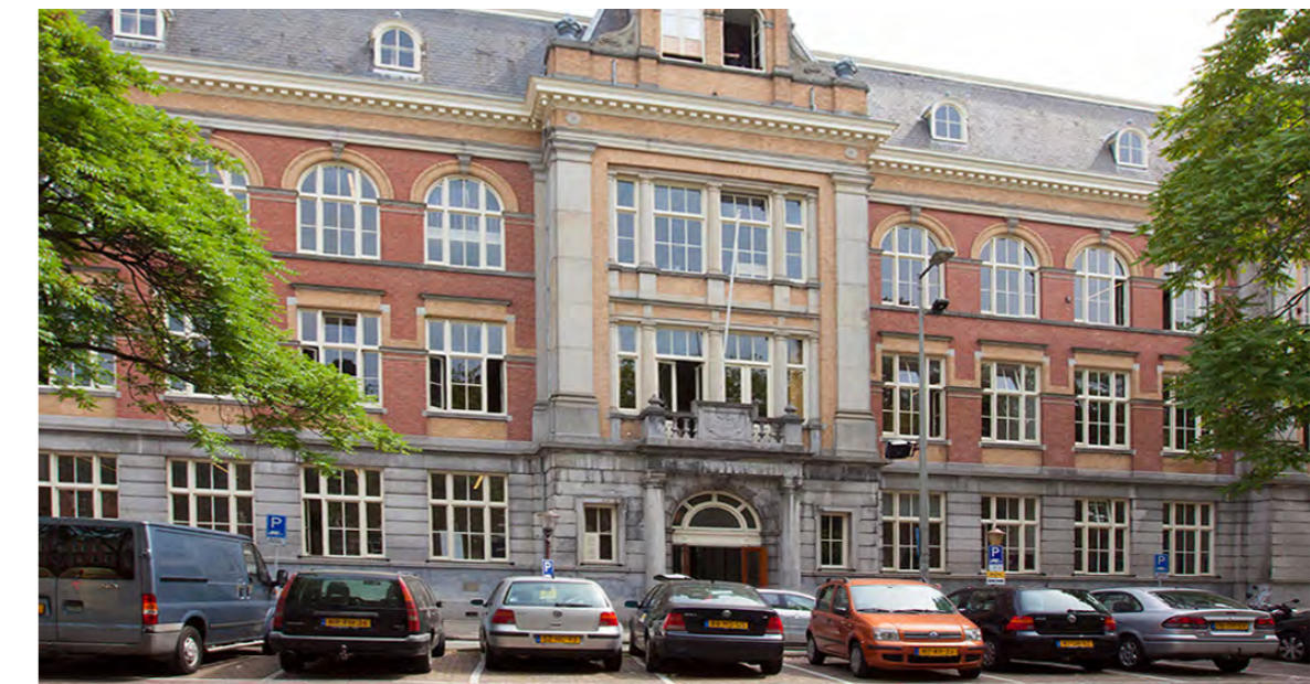
gevel HES gebouw
