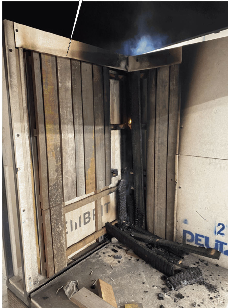
1e proef: brandende achterconstructie en geveldelen
