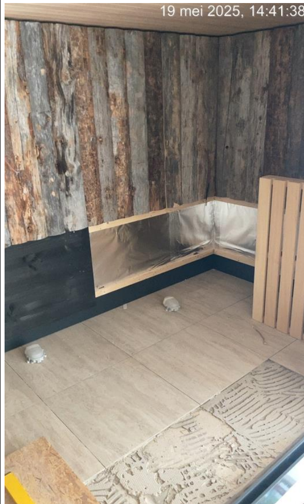
Foto4: Boven vloer van de nieuwe dubbeldeks sauna.
