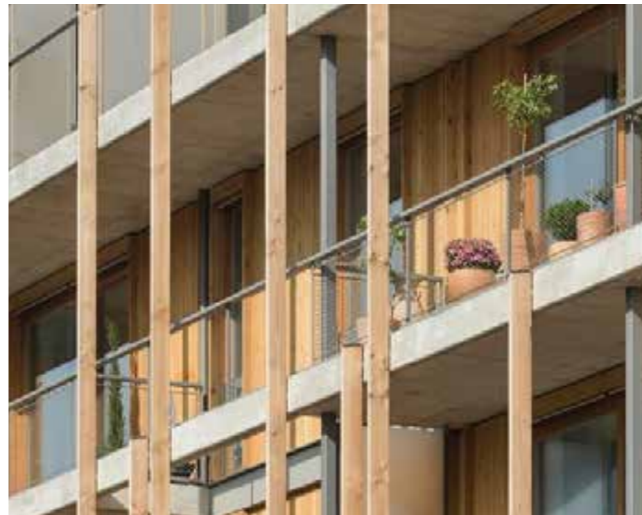
houten constructie galerij
