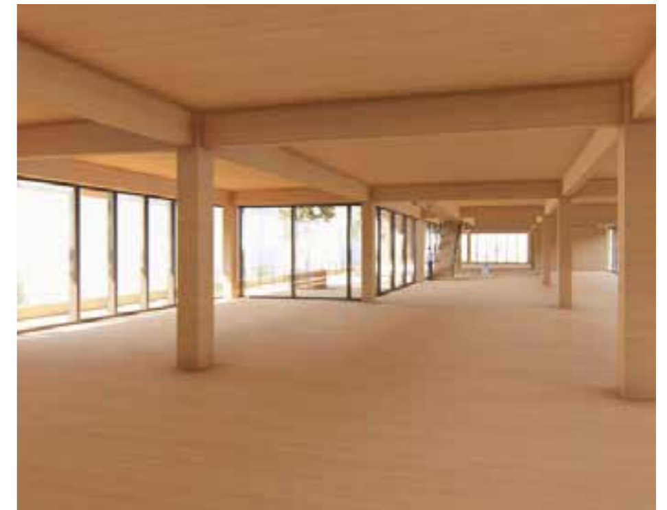
CLT- Balken Ligger constructie
