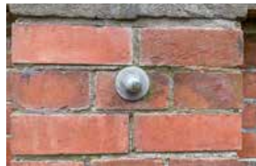
Hulpconstructie: draadeinde met bouten
