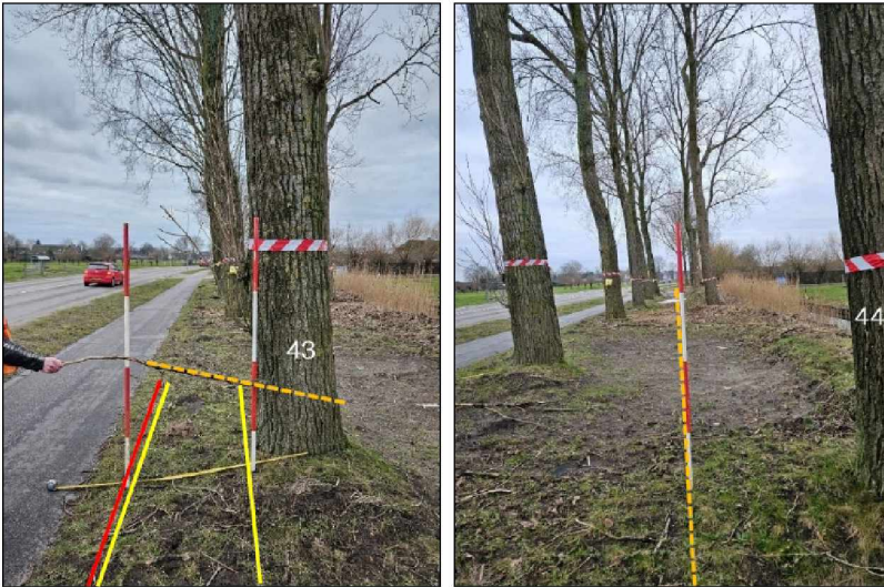
Foto 3 links: Impressie van het te realiseren voetpad (geel), nieuw fietspadprofiel (rood), en de hoogte van de ophoging (oranje stippellijn) bij boomnummer 43. Foto 4 rechts: Impressie van de aansluiting (oranje stippellijn) van het talud op het huidige maaiveld binnen de wortelprojectie van boomnummer 44.
